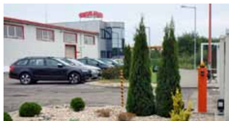
Modernizaci prošly nejen výrobní provozy, ale i celý areál firmy
