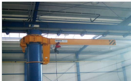
Sloupový jeřáb GSOJ 2t/6m kolem sloupu haly
