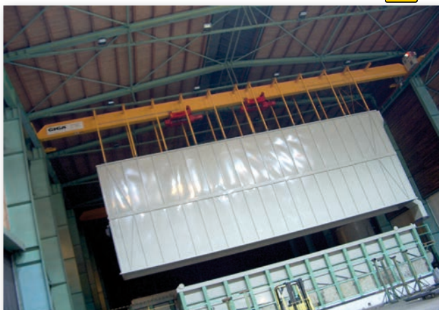
Jednosíkový mostový jeřáb GJM 2,5t+2,5t/23,8m do zinkovny s odsávací jednotkou
