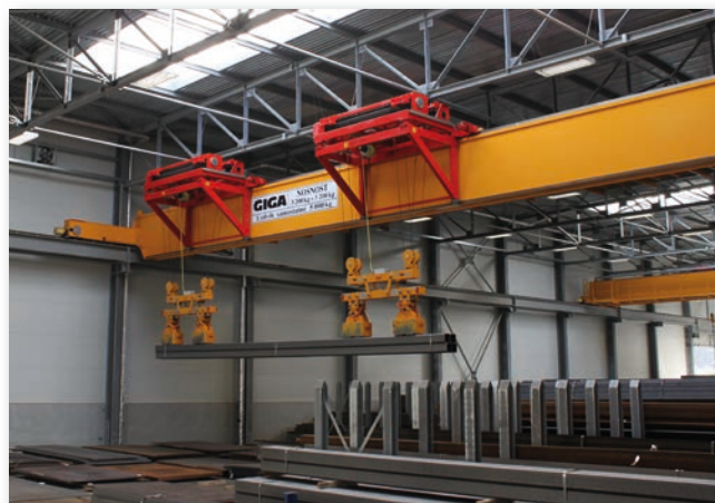
Mostový jeřáb GKMJ 3,2t+3,2t/26,5m s konzolovými kočkami a magnetovými traverzami
