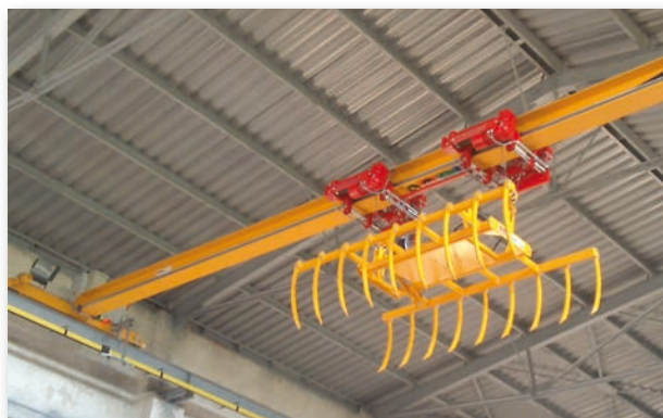
Mostový jeřáb GJMJ 2x0,8t/16m s drapákem pro zvedání sena. Jeřáb je osazen systémem „antikyv“.
