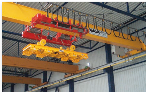
Mostový jeřáb GIGA typ GJMJ 4,4t/27,5m s magnetovou traverzou s lanovou stabilizací
